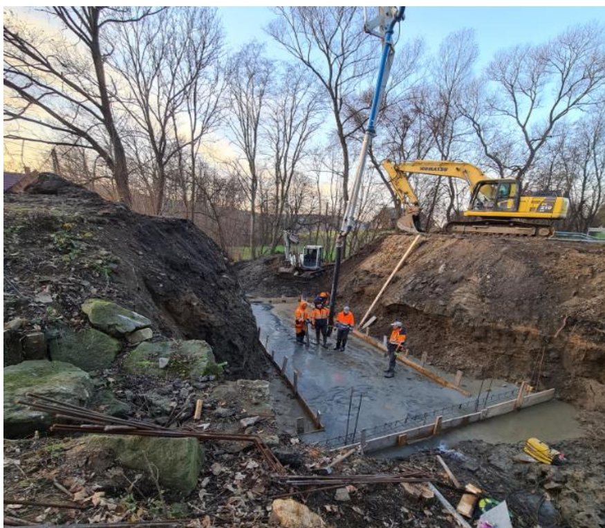
Przepust ramowy w ciągu drogi Raciechowice – Poznachowice Górne
