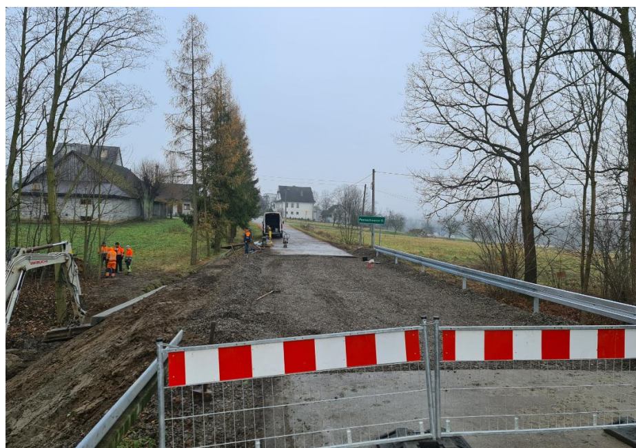
Przepust ramowy w ciągu drogi Raciechowice – Poznachowice Górne
