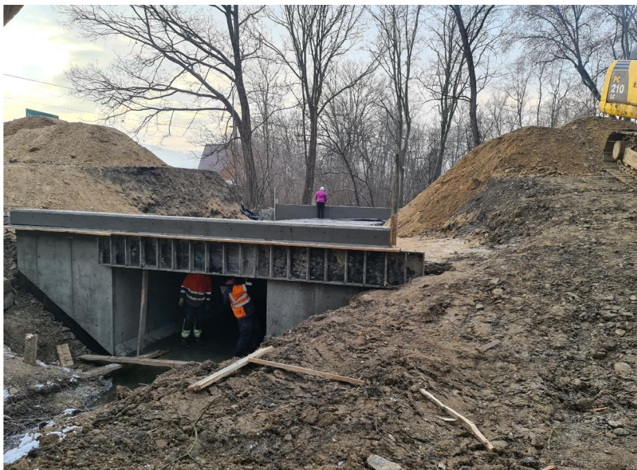
Przepust ramowy w ciągu drogi Raciechowice – Poznachowice Górne
